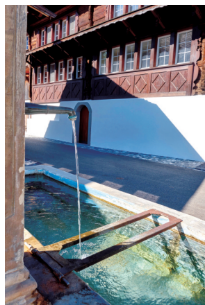
图14 翻新后，立面的原有砌块结构，清晰可见。次级屋顶是新的。前景是一个村庄喷泉的照片
